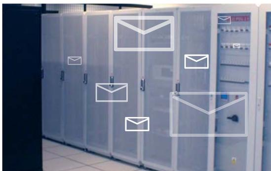
Les accès en sont strictement contrôlés par badge, circuits de vidéo-surveillance. Les alimentations électriques sont en double pénétration EDF, sécurisées par des groupes électrogènes à grande autonomie (3 semaines). Les normes de protection et résistance des matériaux, de sécurité incendie et de climatisation sont également poussées à la perfection. La redondance des datacenters vient compléter **la garantie de très haute disponibilité de nos infrastructures**.
